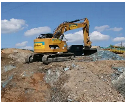
Schicht um Schicht trägt ein Bagger den belasteten Boden ab.
