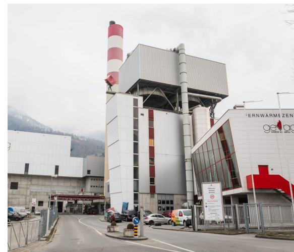
Fernwärmezentrale in Chur (Foto: Fernwärme Chur AG).
